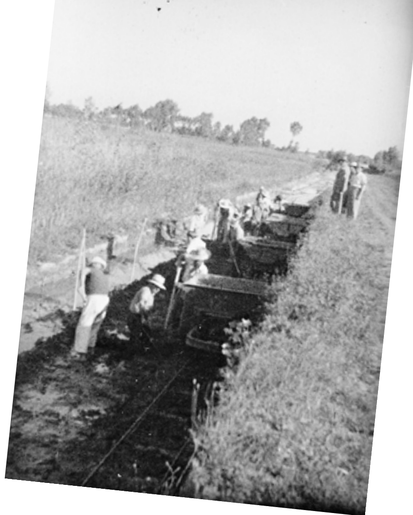
Operai al lavoro e in posa sui vagoni del trenino per il trasporto della torba Workers at work and posing on the wagons of the peat transport train
