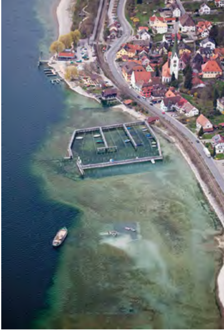
Sipplingen-Osthafen 2008. Seebürtiges Einbringen einer Kiesabdeckung auf Geotextilbahnen im Rahmen des Interreg IV-Projektes.
