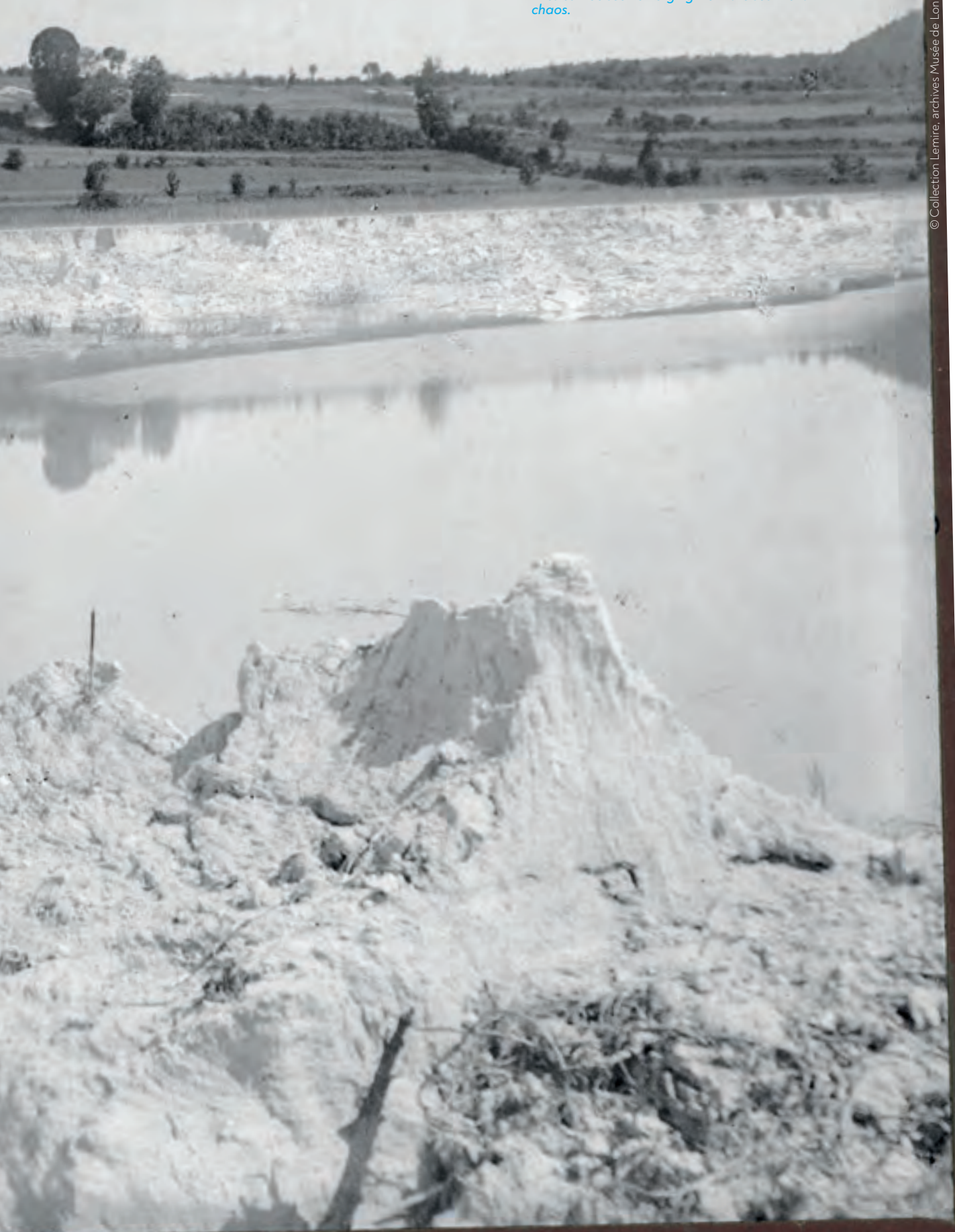
Vue sur les glissements littoraux de la rive ouest en 1904. On aperçoit des pieux qui émergent du chaos de sédiments. View of the West Bank landslides in 1904. Piles can be seen emerging from the sediment chaos.
